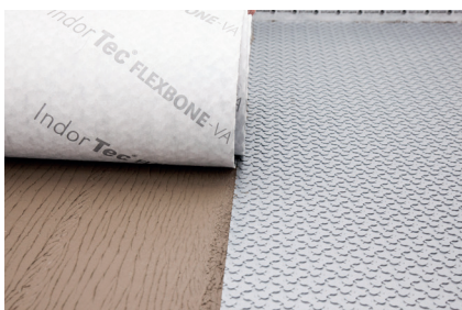
7. Joindre ARDEX FLEXBONE® bout à bout.
