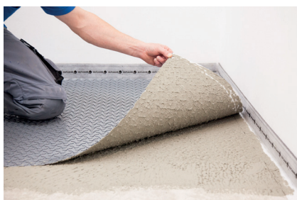
5. insérer la natte ARDEX FLEXBONE® préalablement découpée avec le nontissé dans la couche de mortier-colle encore fraîche...
