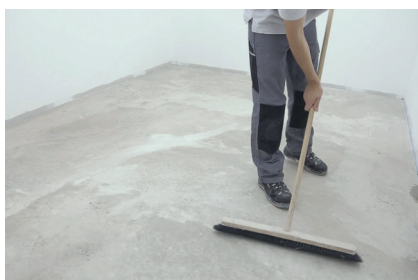
2. Nettoyage et application d'un primaire sur le support
