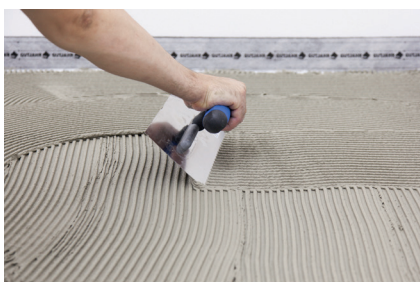
4. Appliquer le mortier-colle adapté au support à l'aide d'une truelle dentée de 6 mm et...
