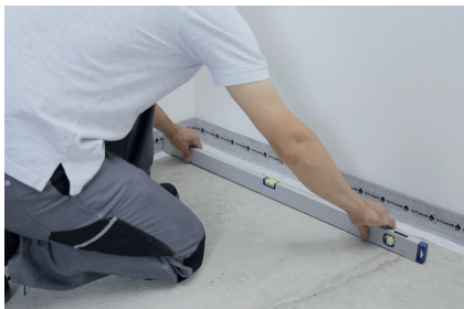
1. Vérification du support quant à sa compatibilité et sa planéité
