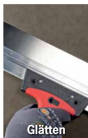
Verputzen von Kabelschlitzen
