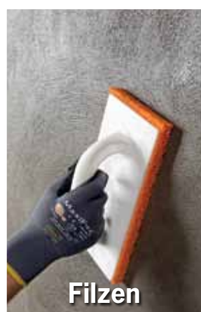
Verputzen von Kabelschlitzen
