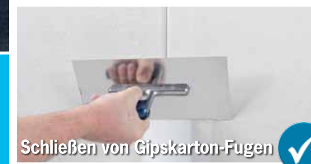
Keilförmiges Anspachteln
