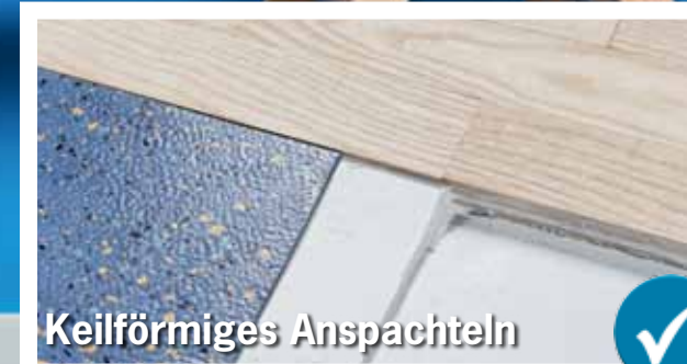
Verspachteln von Bodenplatten
