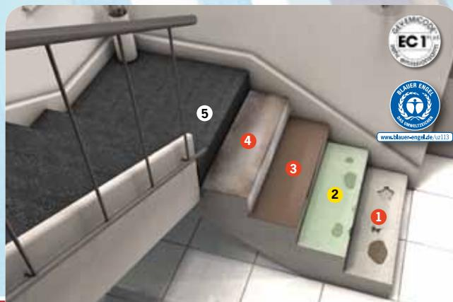
① Optional: Ausbrüche reparieren mit **ARDEX A 45 M** Standfeste Füllmasse oder **ARDEX FIX** Blitzspachtel
