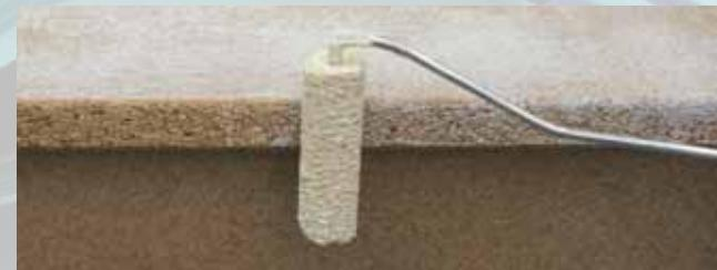
**Sofortige Anfangshaftung nach Trocknung.** Die getrockneten Klebstoffflächen werden mit kurzem, hohem Druck aufeinander gepresst, wodurch eine Verfilmung entsteht und der Klebstoff unmittelbar und extrem stark haftet.
